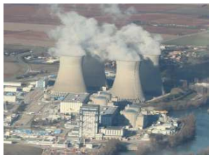
5 - Bugey 1 Ain, à 40 km de Lyon Réacteur UNGG Mise en service : 1972 Date d'arrêt : 1994
